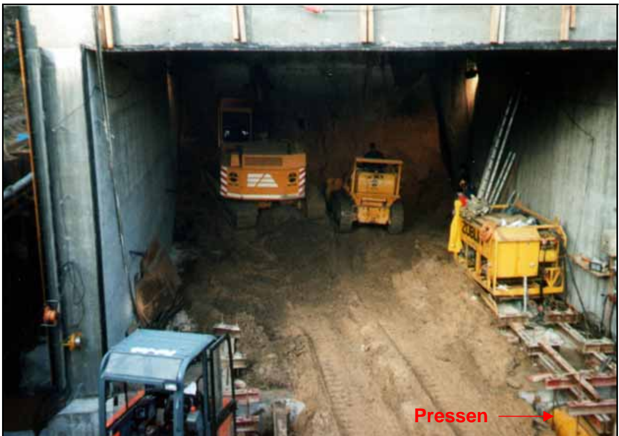
Bild 17: Aushubarbeiten während des Einpressvorgangs (EÜ Schifferstadt) /2/
