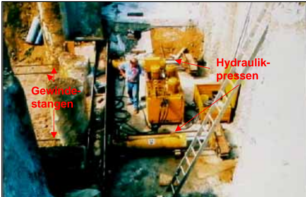
Bild 24: Presseneinrichtung beim Einzugverfahren /2/
