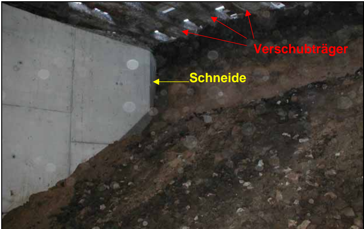
Bild 16: Ortsbrust während des Einpressvorgangs /2/
