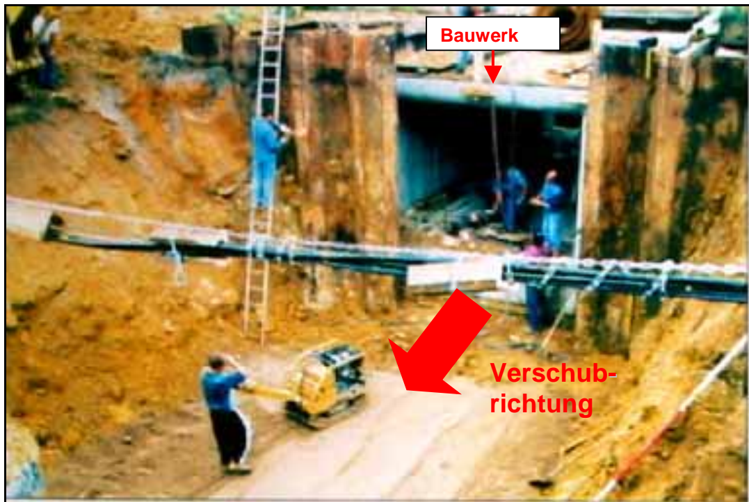
Bild 20: Herstellung des Planums /2/
