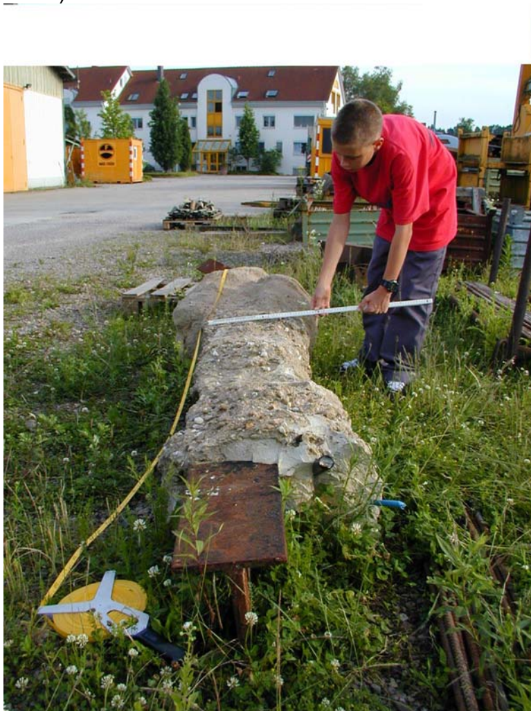
Bild 4: Ausgegrabener Rüttel-Injektionspfahl nach Beprobung, Baustelle: Eisenbahnüberführung Leimen-St.Ilgen, 1999, Baugrund: schluffige Kiessande des Rheintals.
